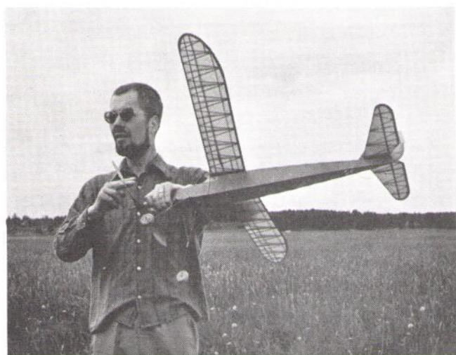
Meteor heter denna modell och är från 1947, varför den inte kan anses som en äkta oldtimer. OBS Enbent landningsställ men dubbelfenor ger tre kontaktpunkter för markstart. S O Lindén visar SMFF-dekalen.
