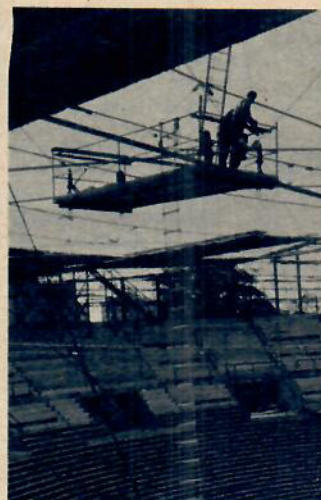
Taket bärs upp av linor som hålls på plats av sicksackmonterade stag.
