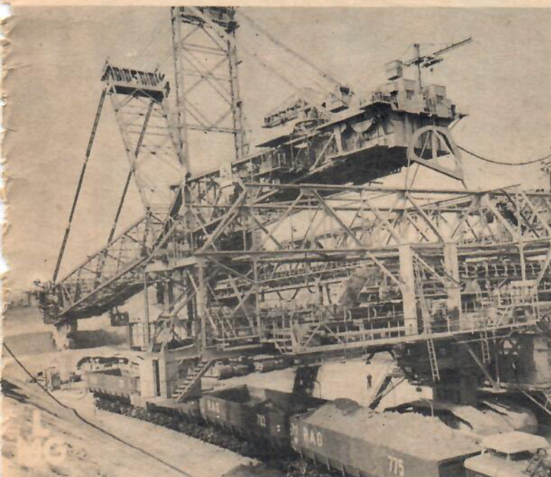
Här är tippningsanordningen, som lastar sand och brunkol i de väntande järnvägsvagnarna. Hela lastningen och tågrangeringen övervakas av två män från grävskopans manövercentral med hjälp av ultrakortvågsändare och fjärrkontroll.
