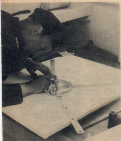
Med en s. k. vinkelavsättare läggs vinklarna ut på mätningsskarta och ett nålstick anger exakta läget.
