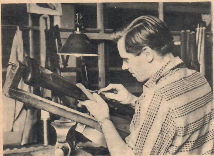
Nätskärningen av stocken är ett fint hantverk och vapnets »adelsmärke». Vapenkännaren ser på denna detalj om han håller i ett kvalitetsgevär.
