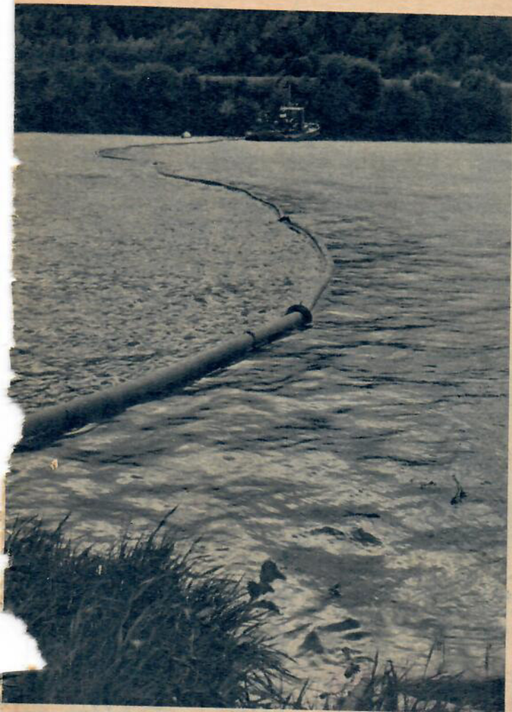
Här har den flytande plastslangen, som lades ut vid Göta, hejdat oljans framfart mot Göteborg. Ett effektivt vapen — om man bara kommer i tid!
